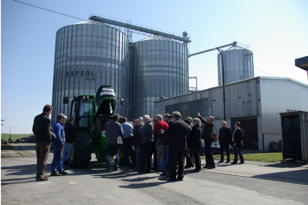
Abbildung 6: Ölmühle der Rapsöl GmbH Großhartmannsdorf, Saatlager und Ölmühlengebäude (Foto: E. Ferchau)
