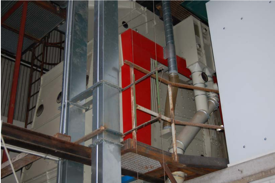
Abbildung 4: Saatreinigung der Rapsöl GmbH Großhartmannsdorf
